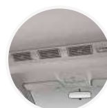
Sistema de ventilación posterior
